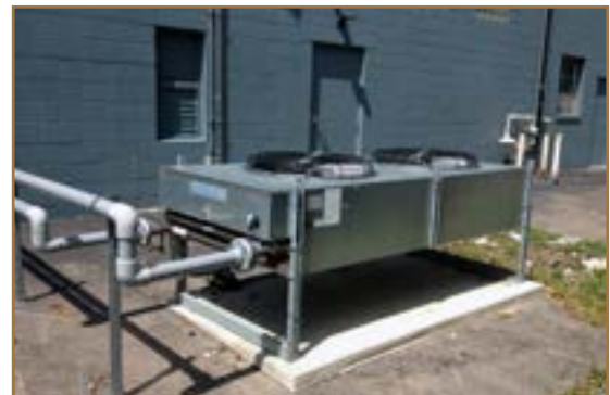
Figure 7, Fan Fin Cooler
